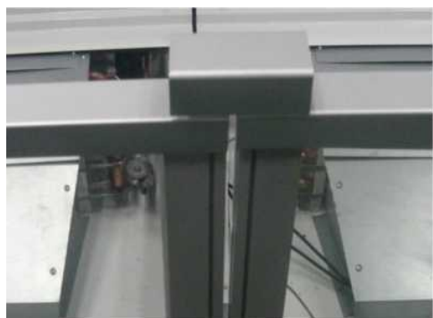
Рис. 5. Детали соединения поручней
